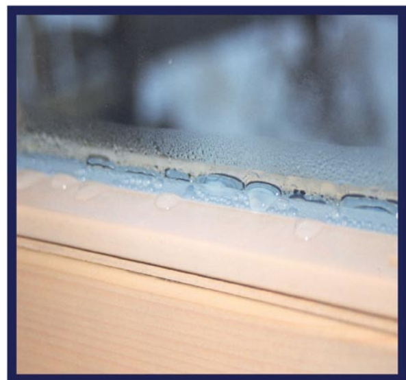
Bild 2 Tauwasserbildung am Glasrand
